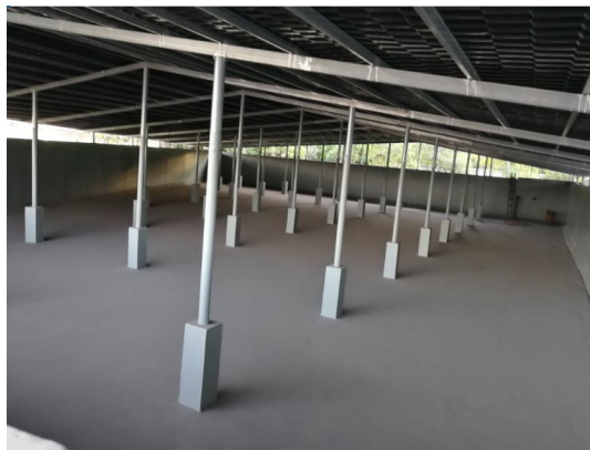
1800m³应急池内部
