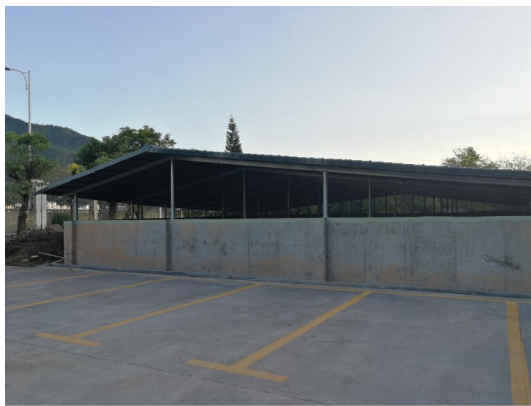
1800m³应急池外观
