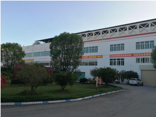
利用金象公司空置厂房建设的一期工程
