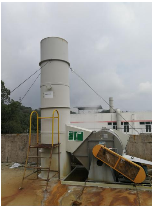
废气排放口设置情况
