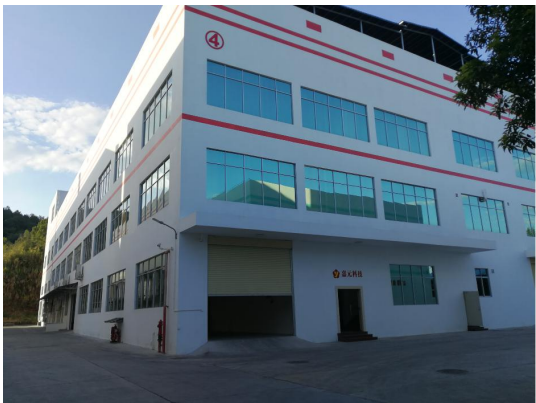
二期的新建厂房
