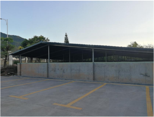
1800m 3 事故应急池
