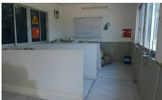
各类危废分区存放，设施有防渗层
