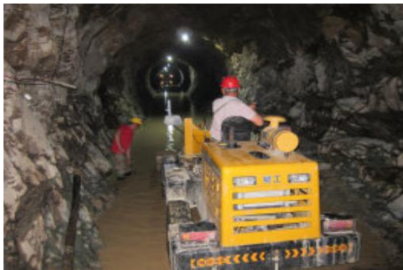
引水隧道施工中
