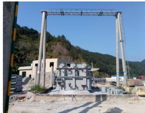
变电站施工中
