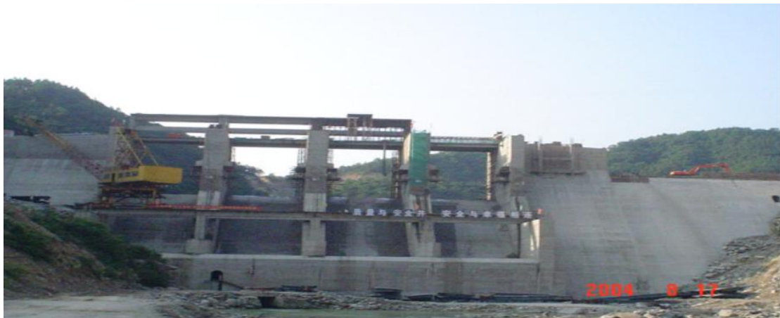
建设中的大坝
